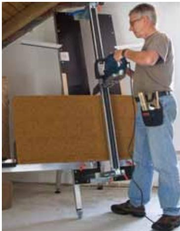
finden auch bei der Verarbeitung kopfüber sicheren Halt in den Gefachen. Die Zugabe um eine gute Klemmwirkung zu erzielen ist mit ca. 10mm anzunehmen. Dies ist auch in Gefachlängsrichtung pro Plattenlänge anzuwenden. Der Zuschnitt erfolgt einfach und unkompliziert mit dem STEICO Dämmstoffmesser, mit einer Stichsäge oder einem elektrischen Fuchsschwanz (jeweils mit Wellenschliffmessern). Ausführliche Informationen zur Schneidetechnik finden Sie unter:
