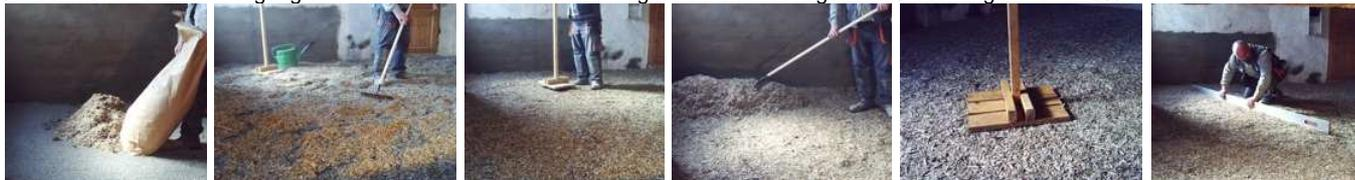
Jede Lage ist mit Harke oder Rechen zu ebenen, mit dem Holzstampfer zu verdichten und zu glätten, wodurch sich die Hanfspäne waagrecht legen und die durch das Schütten verursachten Luftpolster zwischen den Hanfspänen entweichen, und abschließend zu nivellieren. Eventuelle Nivellierleisten nur in die letzte Schicht einbetten.
