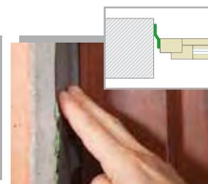
Mauerwerks-/Betonbau, CONTEGA EXO seitlich am Blendrahmen
