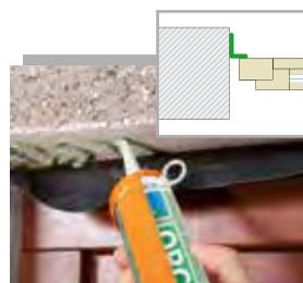
Mauerwerks-/Betonbau, CONTEGA EXO auf dem Blendrahmen
