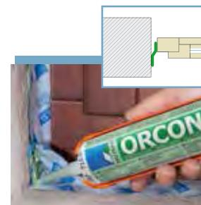
**Mauerwerks-/Betonbau, CONTEGA seitlich am Blendrahmen**
